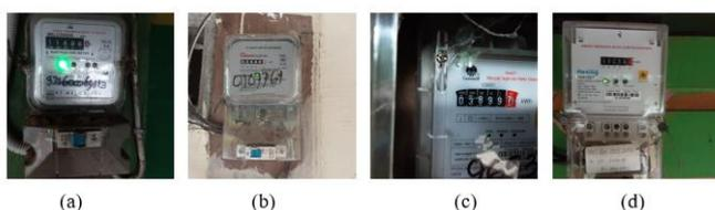
Gambar 10. Jenis Meteran Listrik (a) Melcoinda, (b) SmartMeter, (c) Sanxing, dan (d) Hexing
